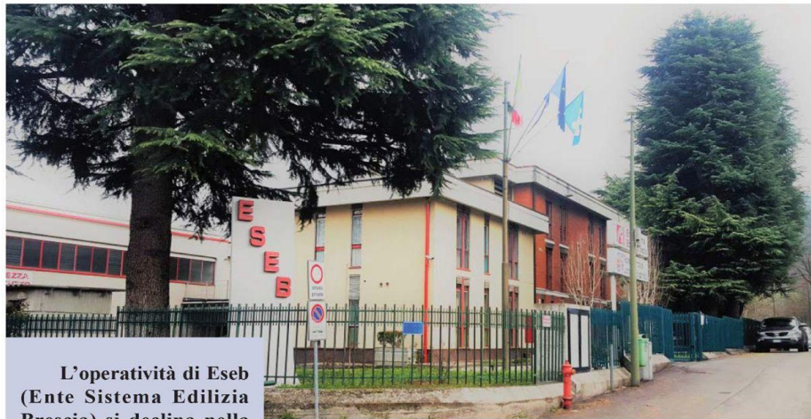
La sede di Ente Sistema Edilizia Brescia, in via Garzetta, a Brescia
